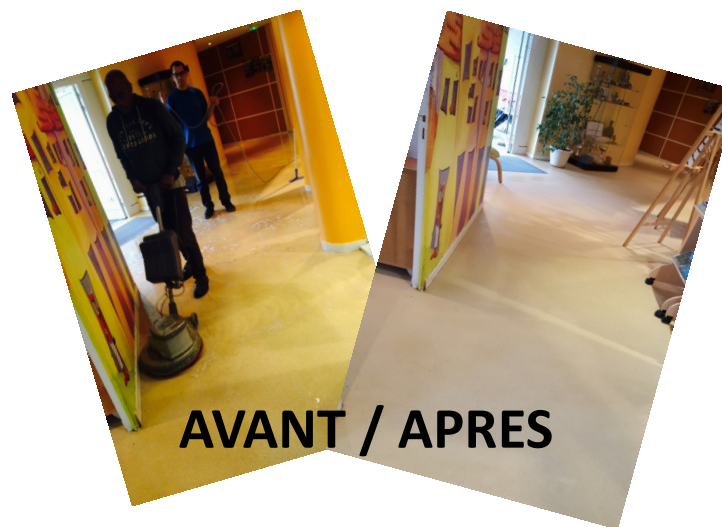
Décapage à l'auto-laveuse
